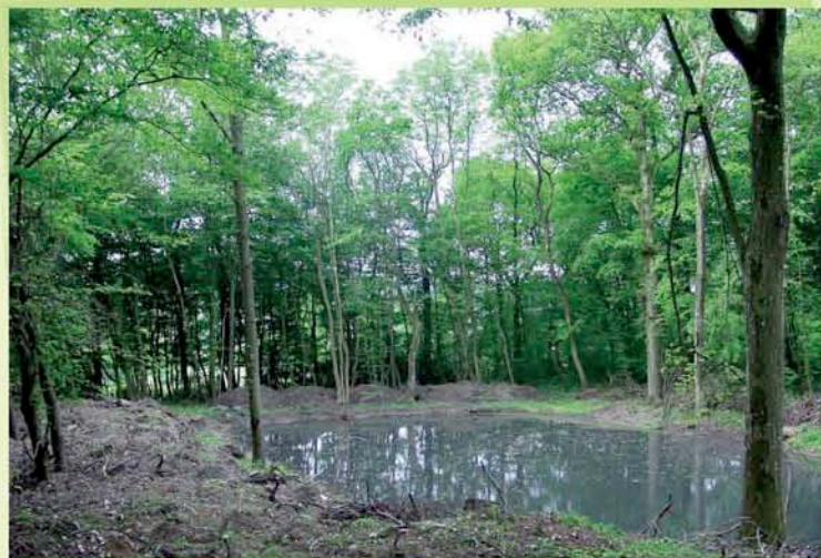
Remodelage et profilage d'une mare forestière
